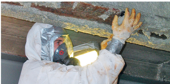
Bonifica da amianto
